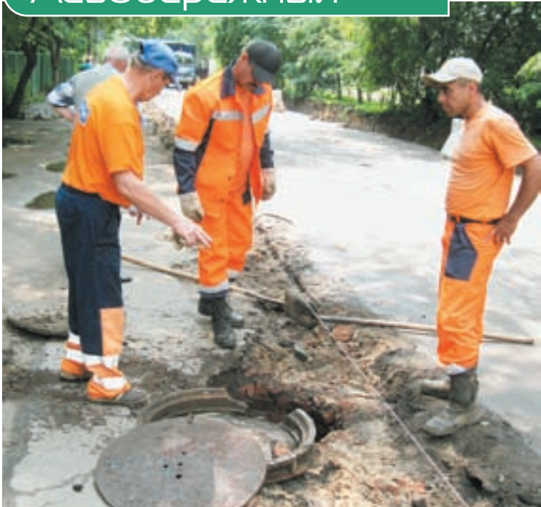
Ремонт пешеходной дорожки у детского сада «Солнышко»
